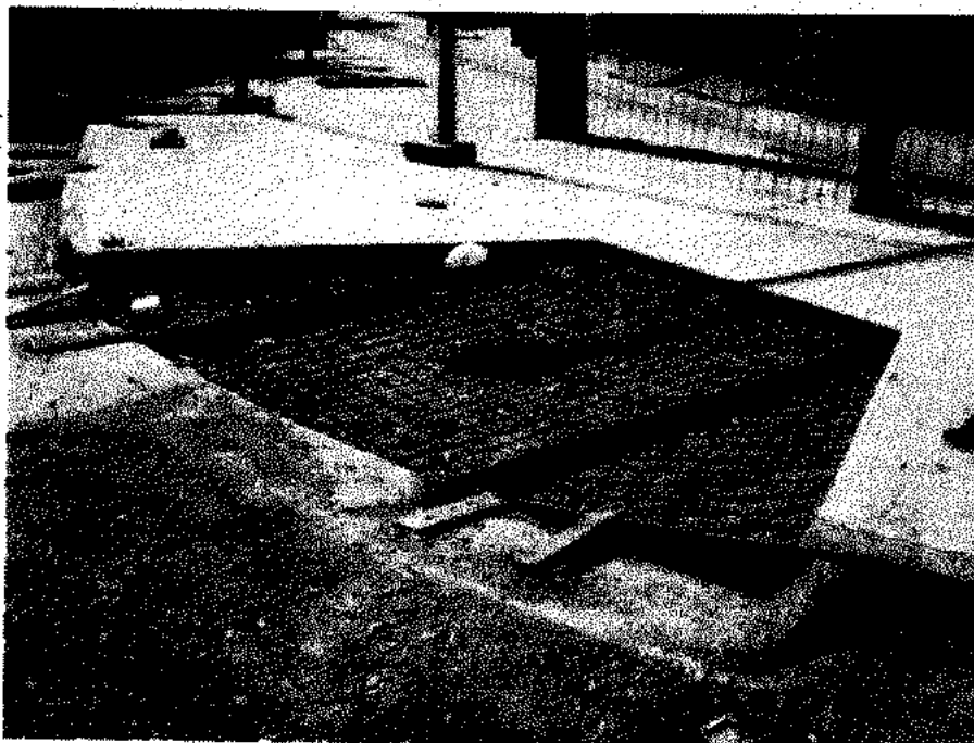
EXECUÇÃO DE RAMPAS DE ACESSO PARA DEFICIENTES
