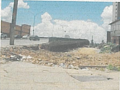
Baixo do Viaduto Pompeia ainda passa por reformas, mesmo liberado após incêndio (Foto: Nathália Duarte/G1)
